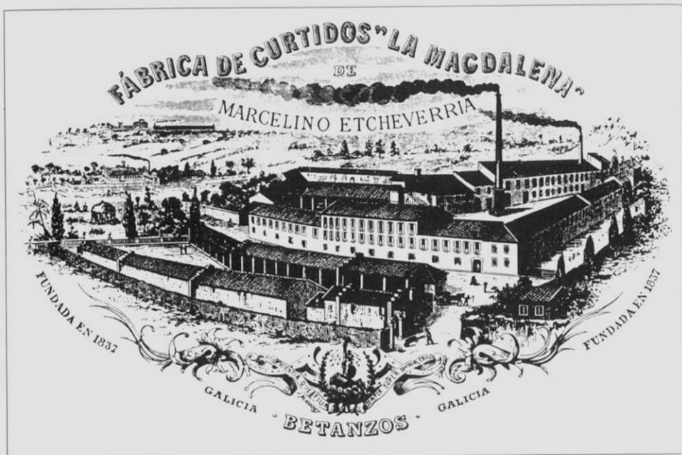
Gravado pouco posterior a 1883. En segundo termo, á dereita, a outra fábrica do Carregal, e ó fondo a silueta do ferrocarril na Infesta. Tomado de A. Erias, "As rías de Betanzos", en A B 1985.
