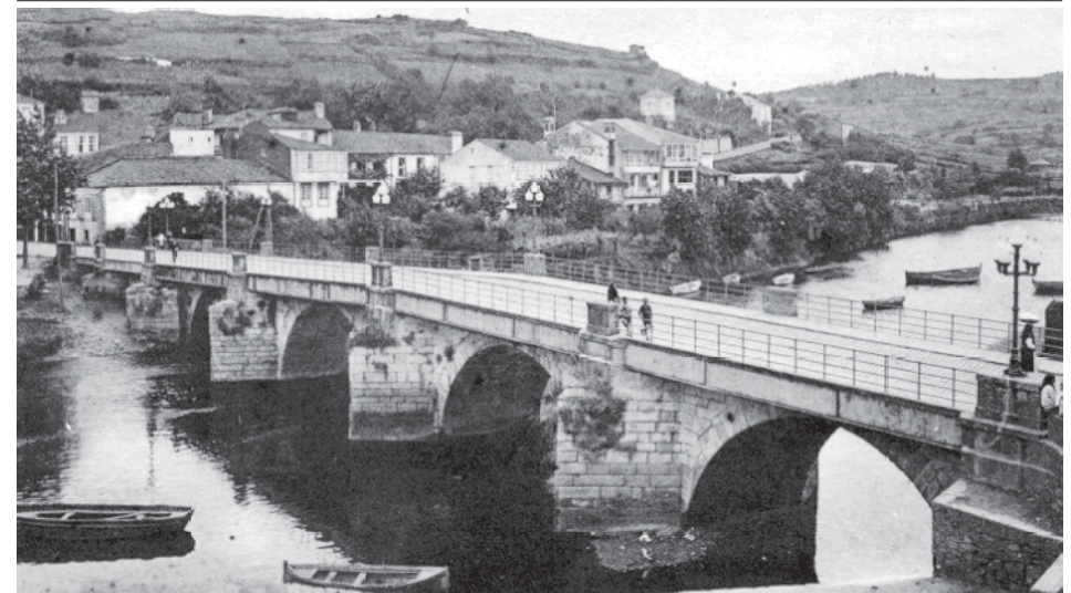
Fig. 13: A Ponte Vella despois das obras de 1897, en que se realizou o ensanche e se colocou a barandilla de ferro. Fotografía realizada nos primeiros anos do s. XX.
