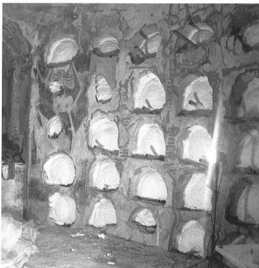
Lámina 8. Proceso del refuerzo interno de la estructura de los nichos con poliuretano expandido.
