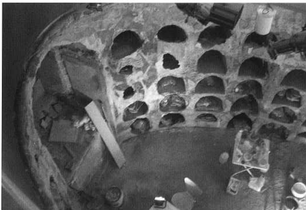
Lámina 6. Imagen cenital de la cripta al comienzo de los trabajos de restauración.
