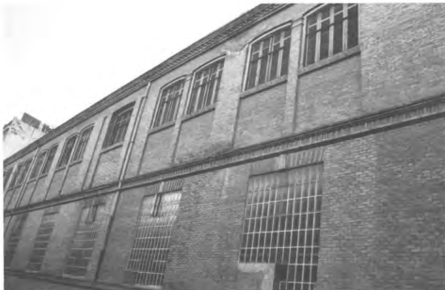
17. Fachada lateral de las antiguas Bodegas Mata
