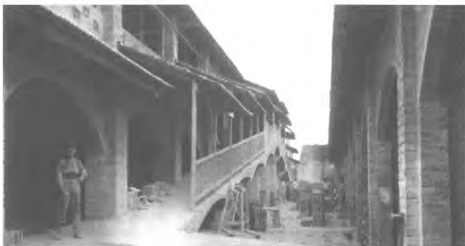
1. Fábrica de ladrillos de Santa Inés en 1900 (Archivo Arenas)
