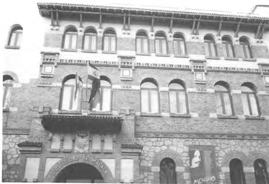
7. Fachada principal del antiguo edificio de Correos (Teodoro Anasagasti, 1920-3)
