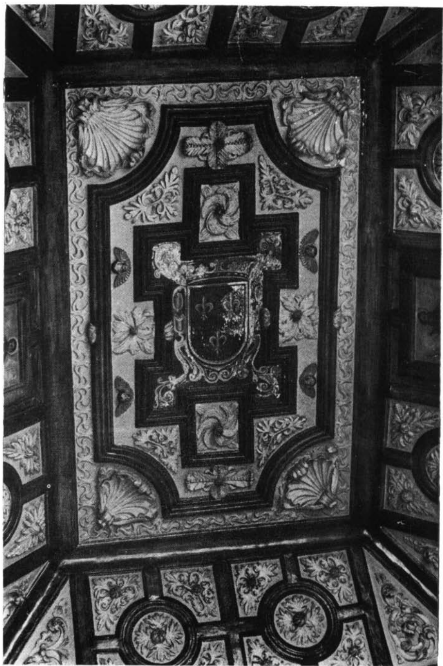
Hospital de San Bernabé: Cúpula de la escalera principal.
