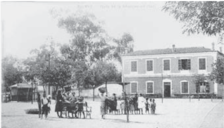
Casa Grande. Dirección de Ferrocarriles Andaluces hasta 1900 (Foto Solano).
