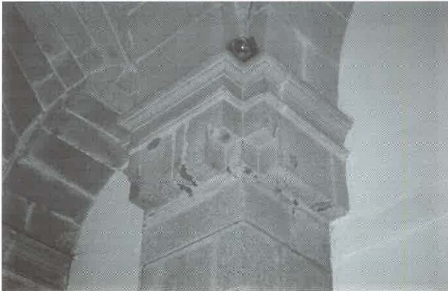
Fig. 12.- Detalle de uno de los pilares.
