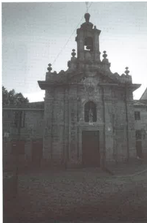
Fig. 4.- Fachada de la capilla del Carmen de Abajo.
