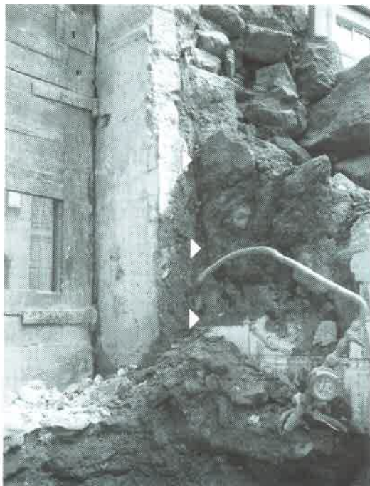
Foto 13: Otro ejemplo de esa pared interior del machón adosándose sobre la cara interior de la fachada del nº 42.
