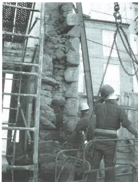
Foto 5: Numeración de los sillares de Porta da Aira en sus caras laterales.
