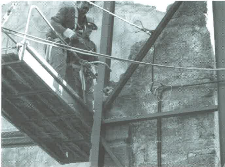
Foto 8: Sistema manual de desmontado de los sillares.
