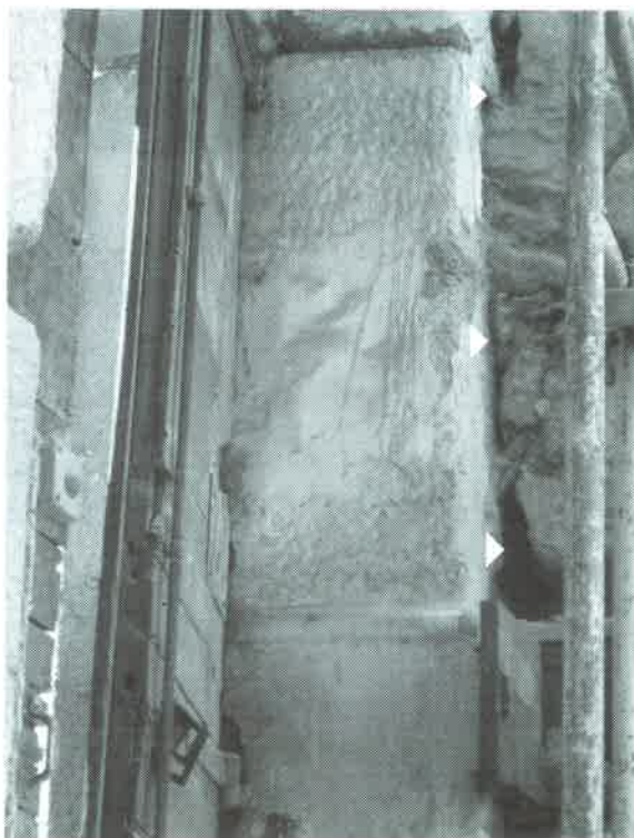
Foto 12: Pared interior del machón adosándose sobre la también cara interior de la fachada del nº 42.
