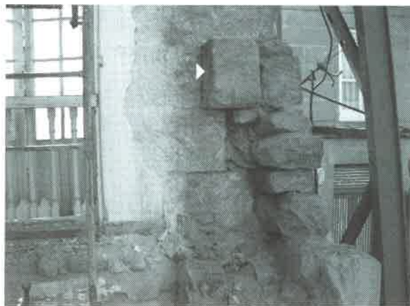
Foto 11: Sillar de la fachada del nº 42 adentrándose en el interior del machón.
