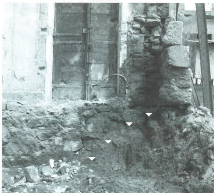
Foto 6: Sillares de la base de Porta da Aira conservados in situ y línea de cimentación (acción 4) de la fachada actual (acción 3)
