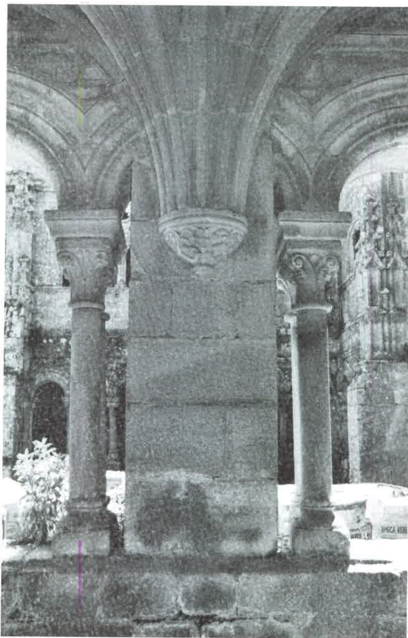
22. San Estevan de Ribas de Sil, Claustro de los Obispos, galería oeste, máchón añadido en el siglo XVI
