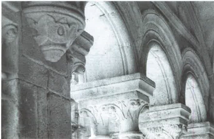
20. San Estevo de Ribas de Sil. Claustro de los Obispos, galería oeste, ménsula de inicios del siglo XVI sobre machón románico.
