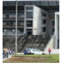
Detalle Edificio Universidad Tecnológica de Pereira
