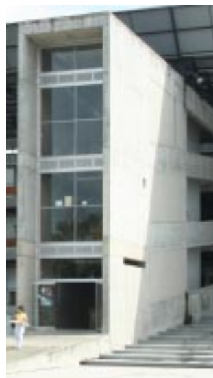
Detalle Edificio Universidad Tecnológica de Pereira
