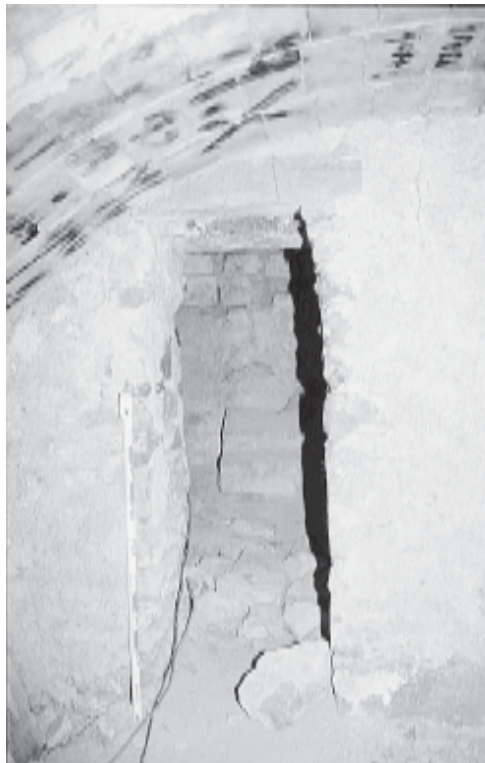
Foto 13: Porta de doble llinda que comunica la nau de la cripta amb la zona absidial.
