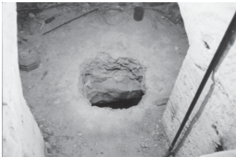
Foto 10: Forat d'accés a la cripta.
