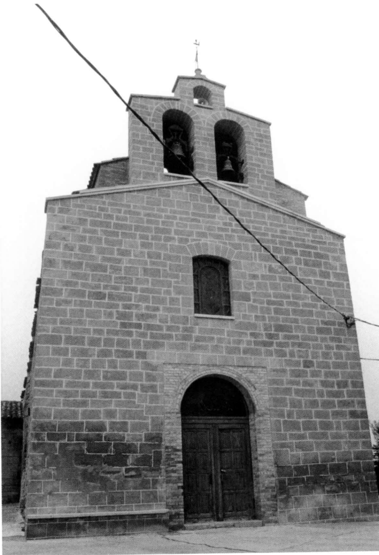
(Fig.15) Vista de la façana de l'església de Vilanova del Segrià (foto: I.Puig).
