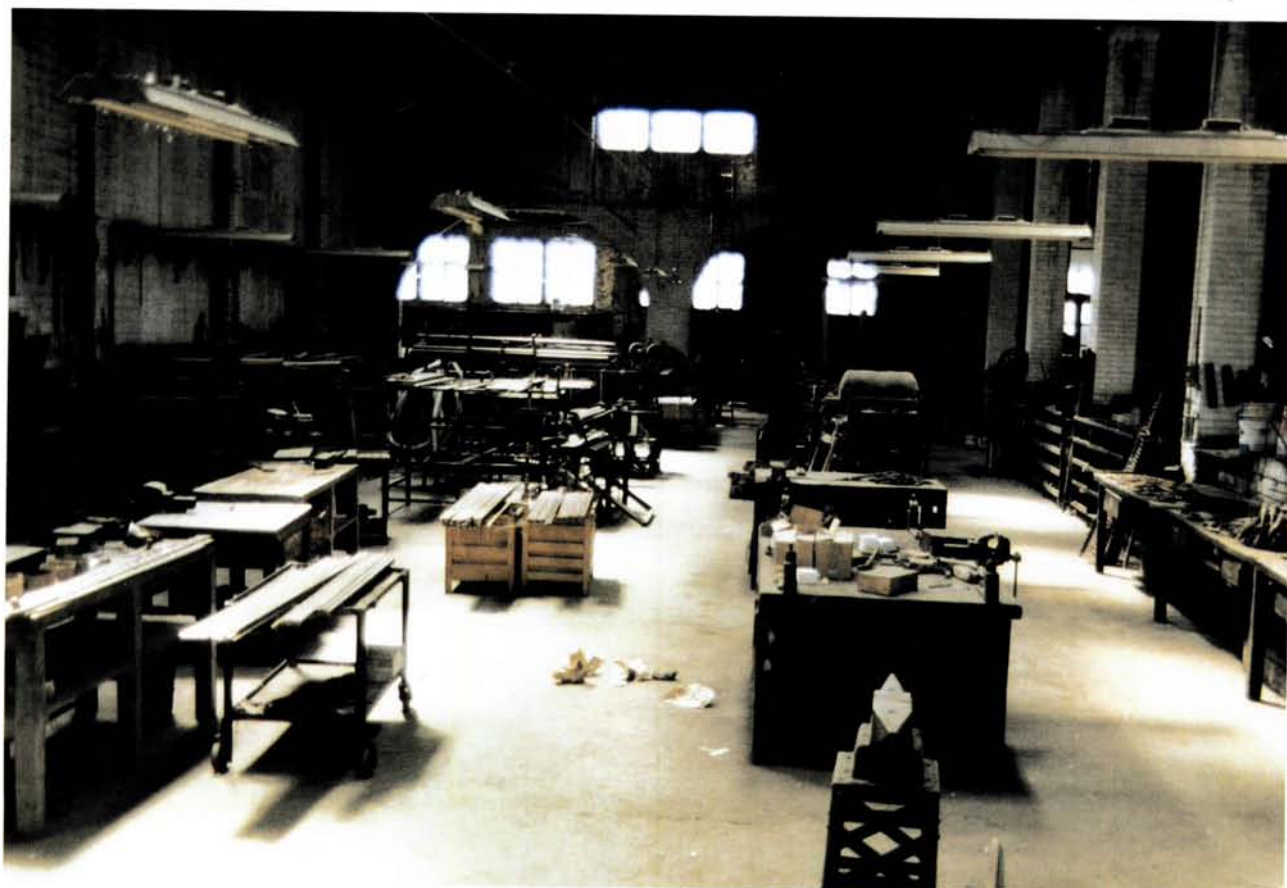
Nau número 7. Muntatge dels tallants; al fons, la Secció de Soldadura. Any 1995. (Fotografia: Oriol Saula. AFMCUT)
