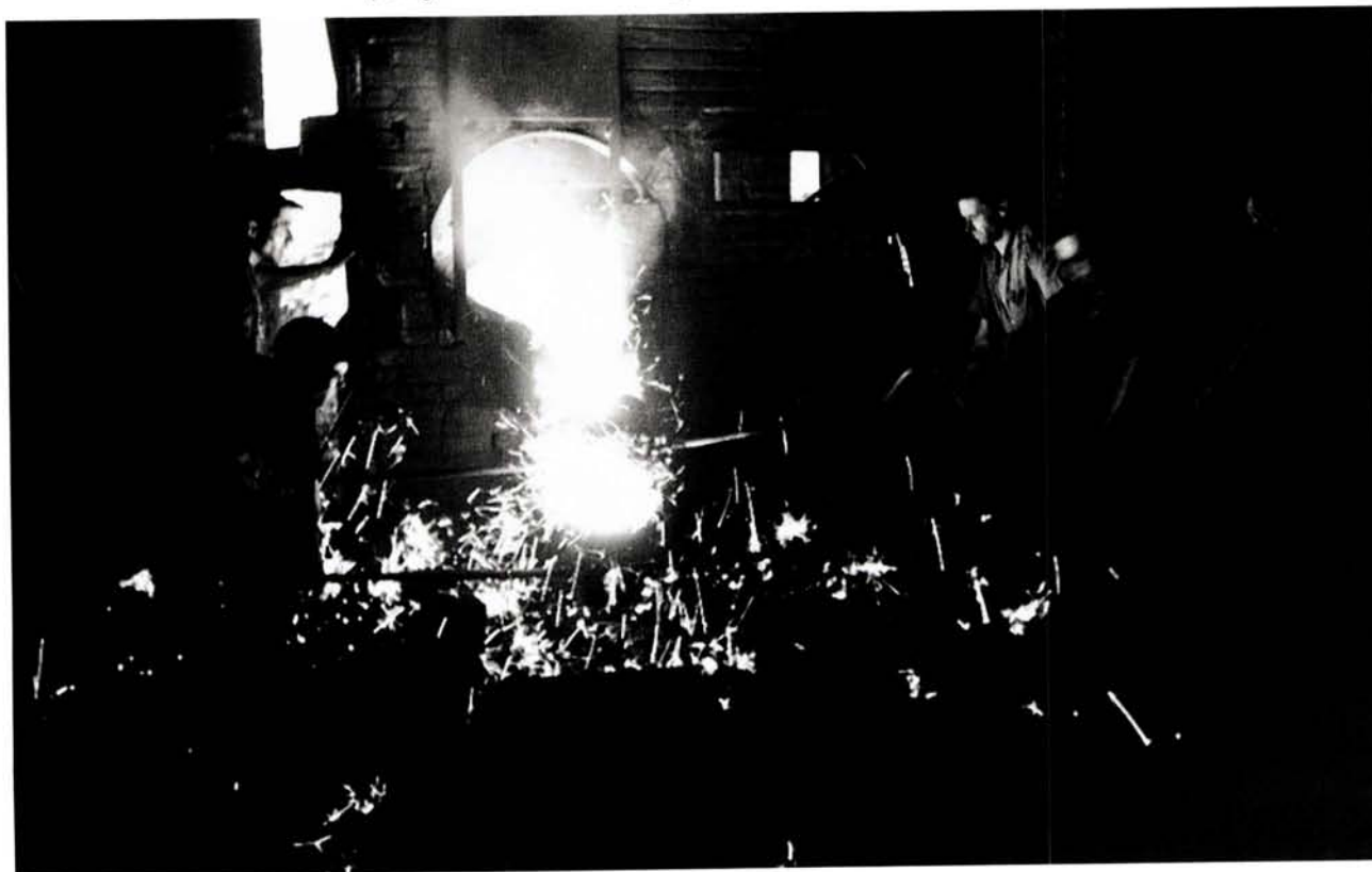
Secció de Foneria. Descàrrega del cubilot una vegada s'ha fos el ferro. Dia 21 de setembre de 1957. (Fotografia: Calafell. Arxiu fotogràfic Comarcal de l'Urgell AHCT)
