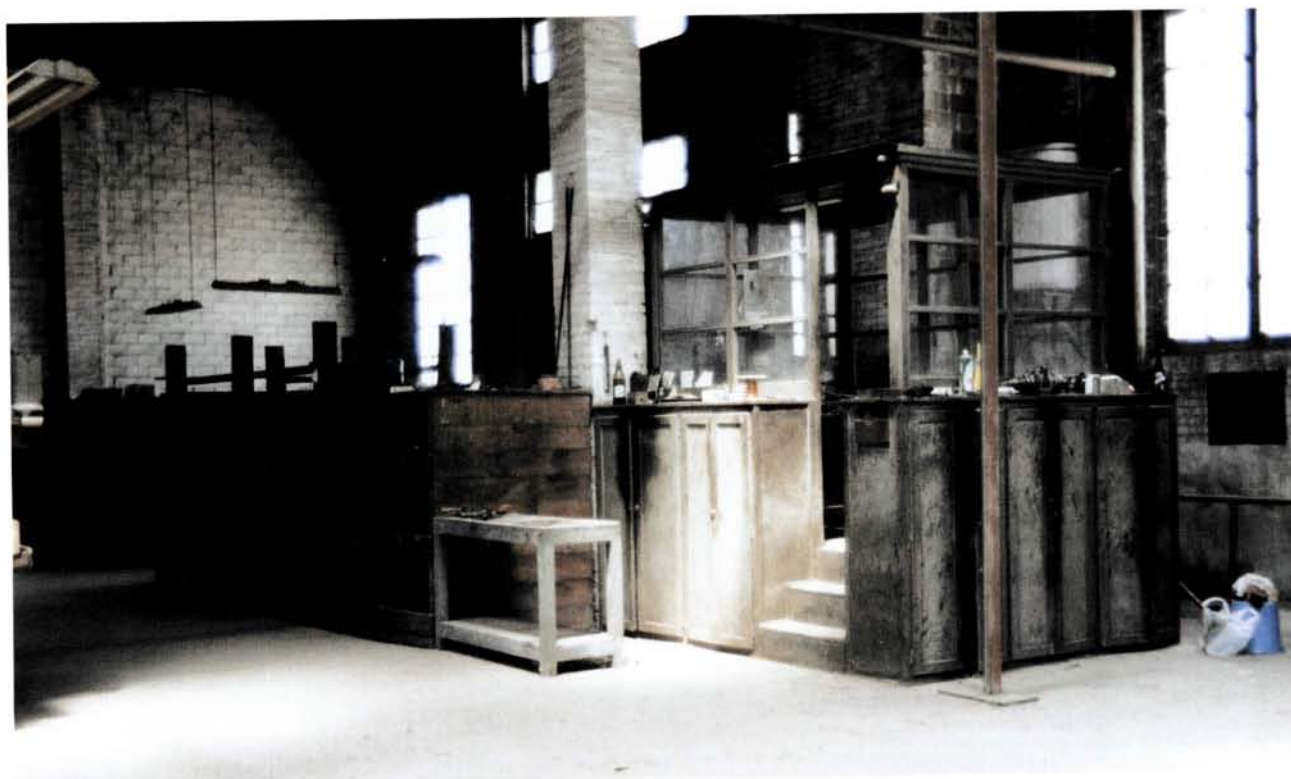
Nau número 8. Cabina de l'encarregat de la secció de segadores. Al fons, les escales per baixar al soterrani, on hi ha les calderes de la calefacció. Any 1995. (Fotografia: Oriol Saula. AFMCUT)
