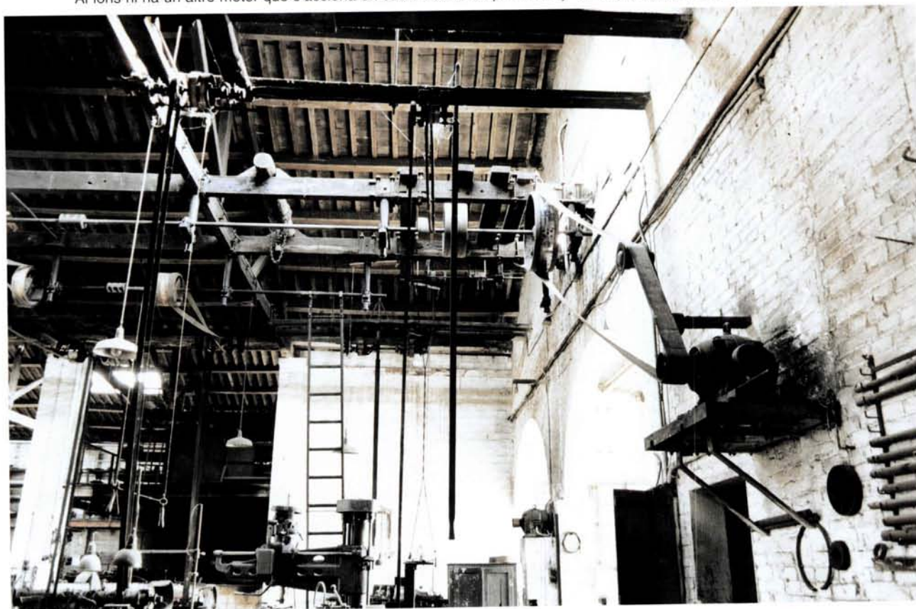
Nau número 5. Detall de l'embarrat accionat per un sol motor. Al fons hi ha un altre motor que s'acciona en cas d'avaría del primer. Any 1995. (Fotografia: Oriol Saula. AFMCUT)
