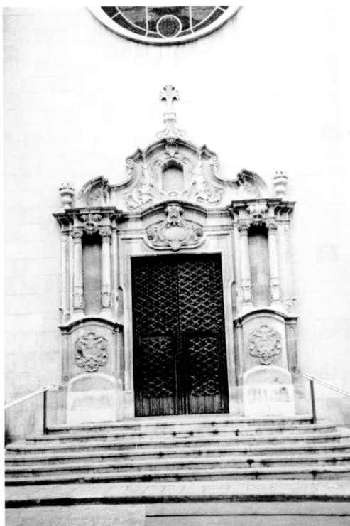
Les obres dels Serradell i la conclusió del campanar
