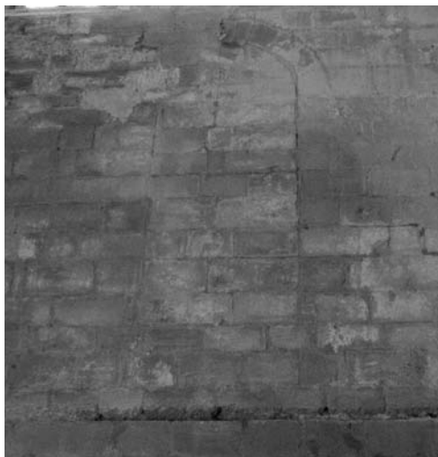
Foto 13. Mur nord de la nau amb un finestral tapiat.
