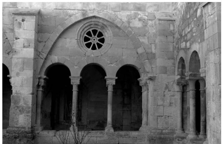
Foto 19. Darrer tram de la nau est del claustre.
