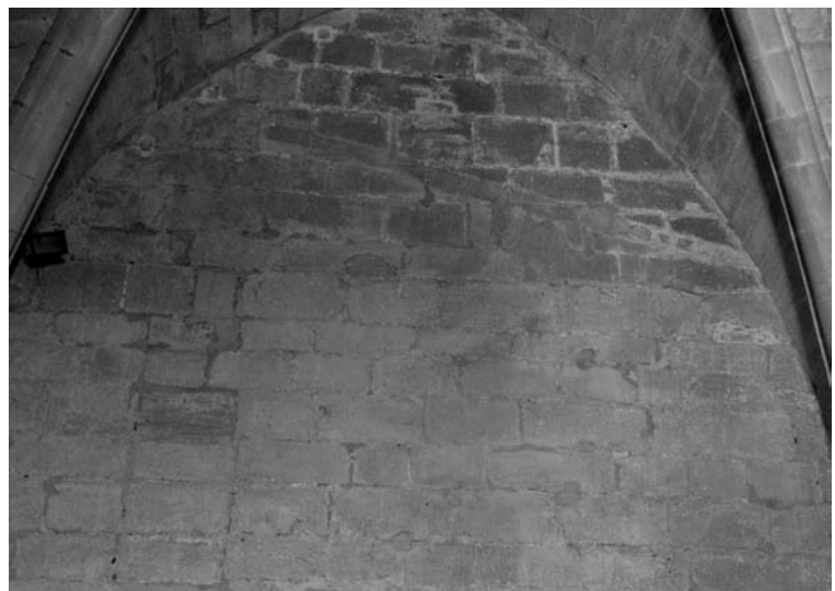
Foto 25. Senyals de construcció en el mur nord de la Sala Capitular.
