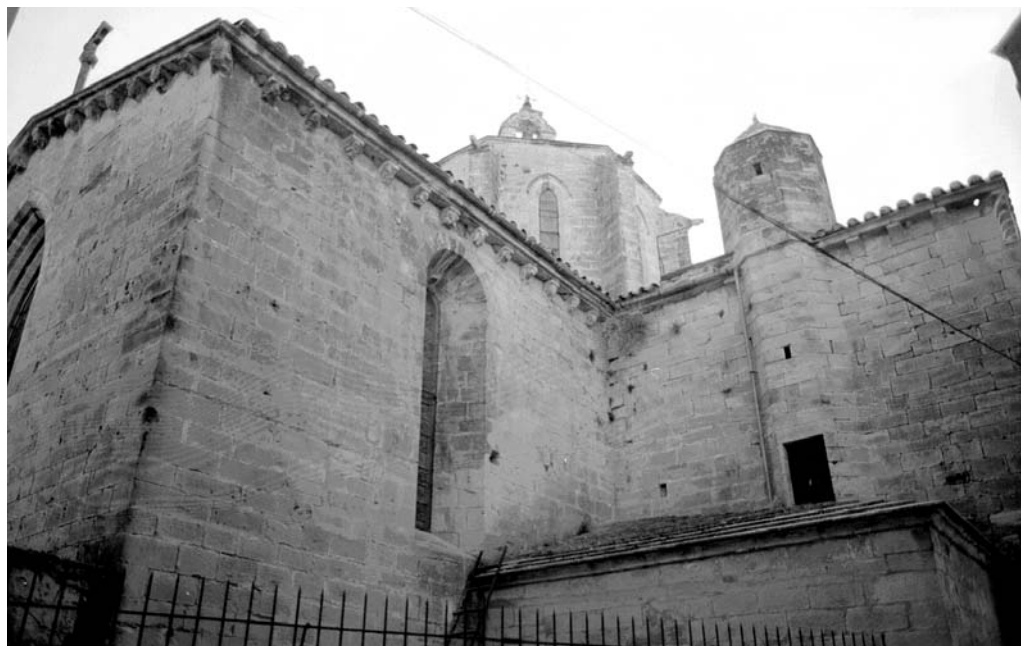
Foto 8. Mur nord de l'absis central, mur est del braç esquerre del creuer i cimbori del creuer.
