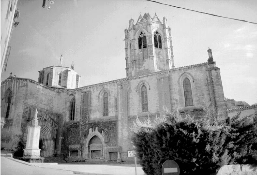
Foto 1. Capçalera, nau i cimboris de l'església vistos des de la cara nord.
