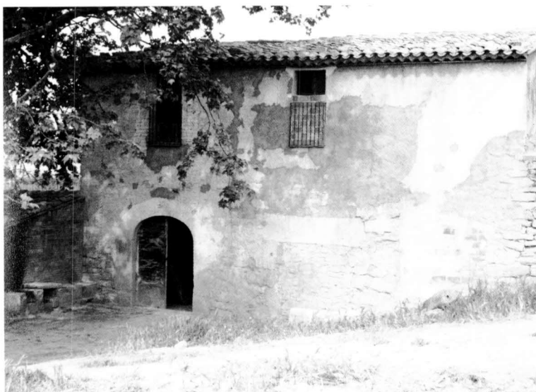
Façana principal, durant les obres de restauració
