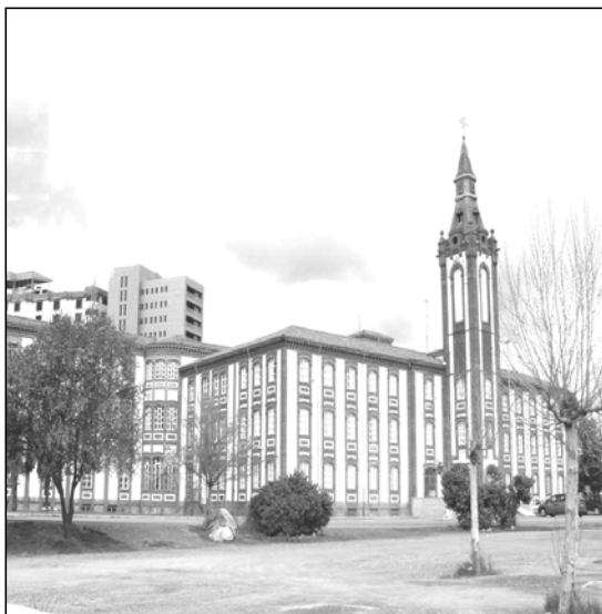
Fachada del actual hospital de San Antonio
