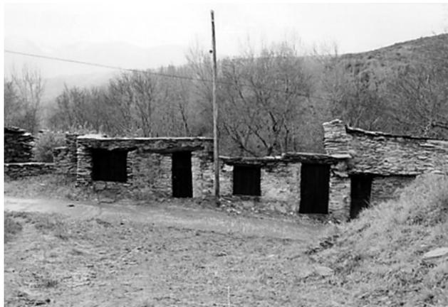
Recuperación de los muros de piedra y protección con cubremuros de losa de pizarra. Tratamiento de la madera.
