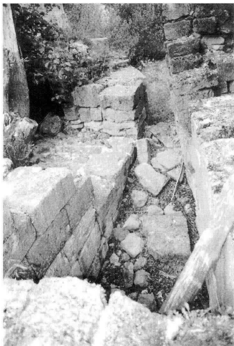
FOTO 5. Restos de la Aceña sexta de la Peral. A la izquierda, la «bollonera» donde se colocaba el «aguatoche». A la derecha, el «canal de desagüe», donde se ponía el «aguatoche» para sacar el agua en las avenidas o cuando la aceña estaba averiada (1999).
