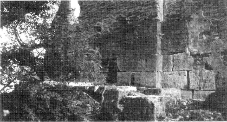
Foto 7. Aceñas de la Peral. Lugar donde estaba colocada la «rueda hidráulica vertical» que se unía a un eje, y éste, a la maquinaria de la aceña.
