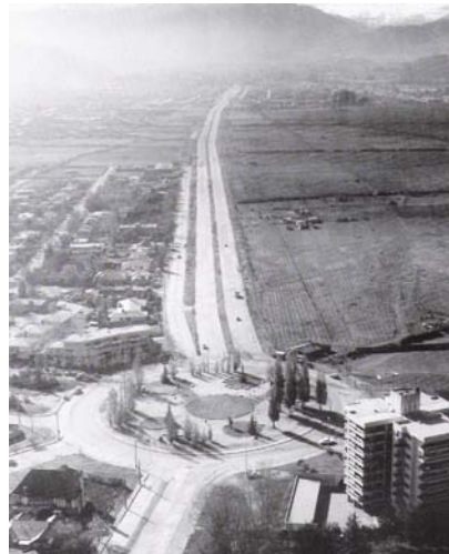
Fig.40. Avda. Kennedy en construcción, a la altura de A. Vespucio, (vista al oriente). Fte.: Album copia: CHILE, M.O.P., D.G.O.P. Transporte Metropolitano- Metrópoli de Santiago - septiembre de 1970 - Infraestructura Urbana del desarrollo Económico y Social 2. Inédito en Archivo de J. PARROCHIA, 2005.
