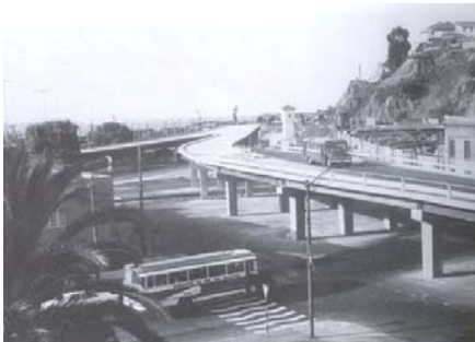
Fig. 20. Tramo inicial de la autopista de Valparaíso a Viña del Mar construido. Vista al norte sobre bifurcación en Barón. Fte.: Foto de G. González G., s/f., inédita en Archivo RR.PP., M.O.P., 1998.
