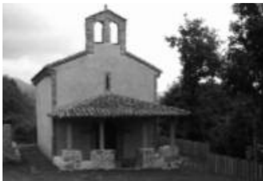
Restauración. – Estado actual.
