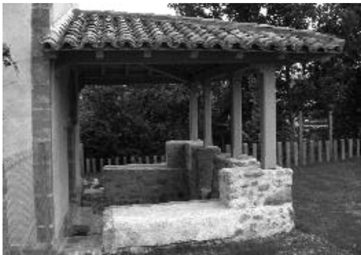
R./ Vista desde el norte del pórtico restaurado.
