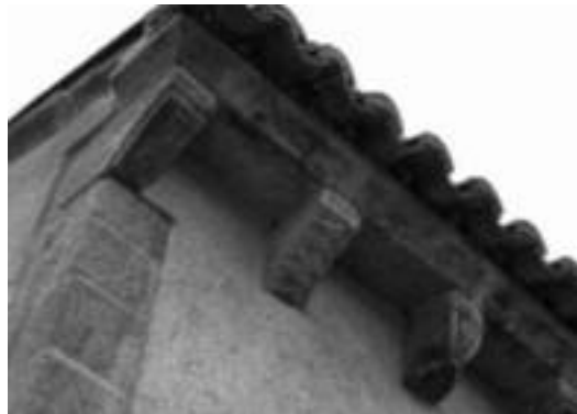
R./ Detalle de esquinial y cornisa.
