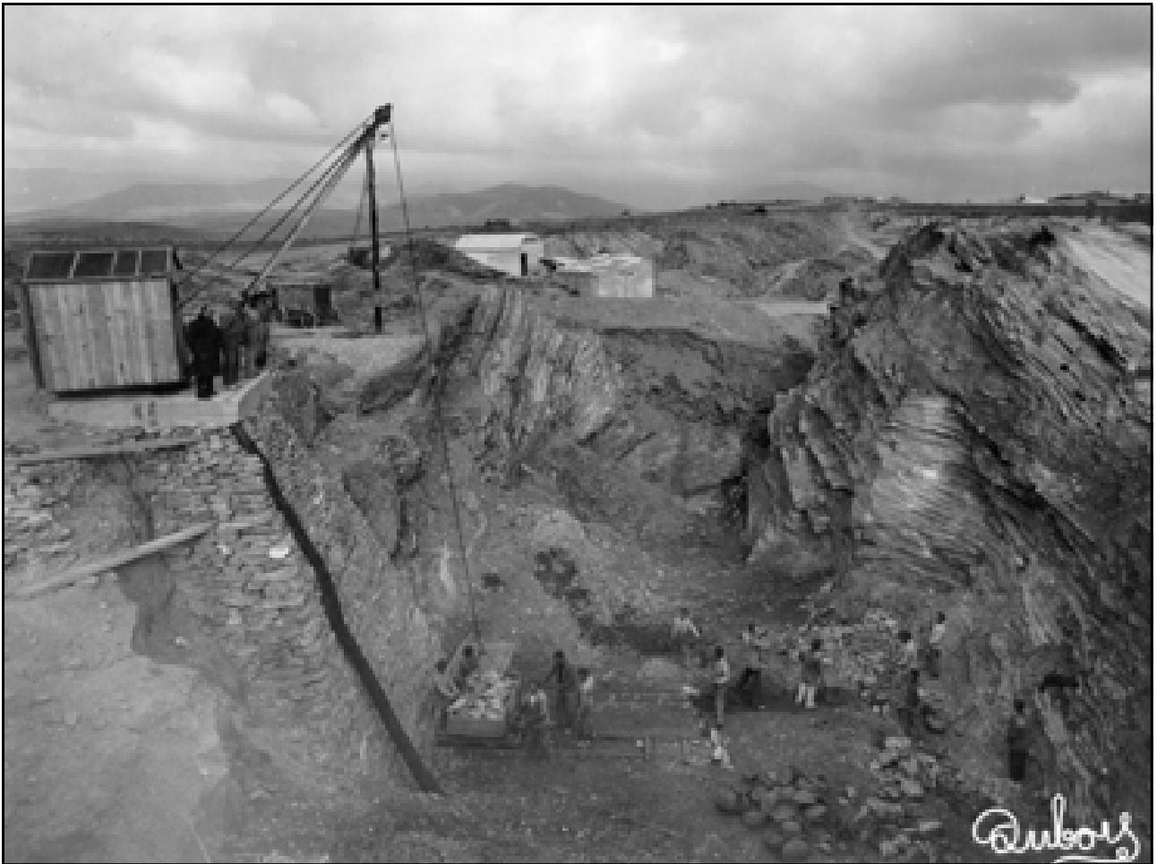
Imagen 6. Impresionante vista del "boquete" abierto en la cantera de Los Guijos. Fotografía tomada en diciembre de 1941 durante las obras de construcción del puerto de Tarifa. De Los Guijos se extraían los mampuestos, mientras que de la otra cantera abierta en La Peña (junto a la torre almenara) se extraía el árido para los hormigones.
