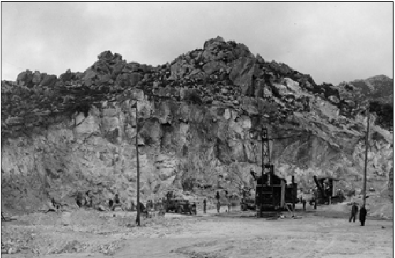
Imagen 7. La cantera de La Peña, de la que se extraía el árido par los hormigones, estuvo activa durante las obras de construcción del puerto de Tarifa. Su frente se encontraba muy próximo a la torre almenara, cuya peña sobre la que se asienta estuvo a punto también de ser excavada para extraer material. Fotografía del año 1941.
