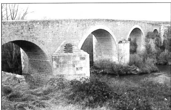
Figura 28. Puente de Vadocondes sobre el Duero. El primer arco, más antiguo, muestra el arranque con otra curvatura, señal de que ha sido reconstruido en época indeterminada.
