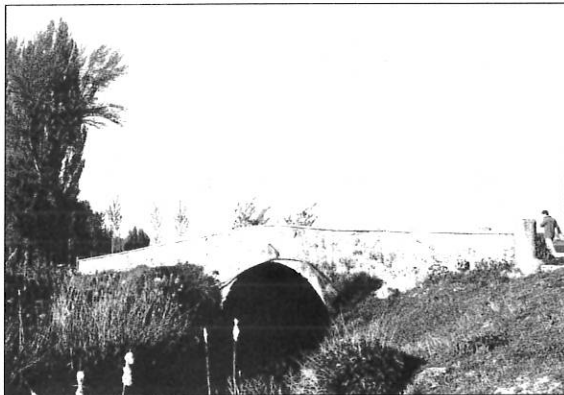
Figura 7. El Puente de Abajo o de la Cañada en Quemada sustituyó a uno de madera. Posiblemente de trata de una construcción del XVII recientemente restaurada.
