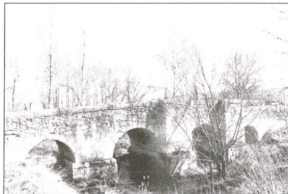
Figura 8. Vista de los espolones del Puente de Arriba en Pinilla Trasmonte, con sus dos exiguos apartaderos. A la izquierda, un quinto arco permanece enterrado bajo el terreno.
