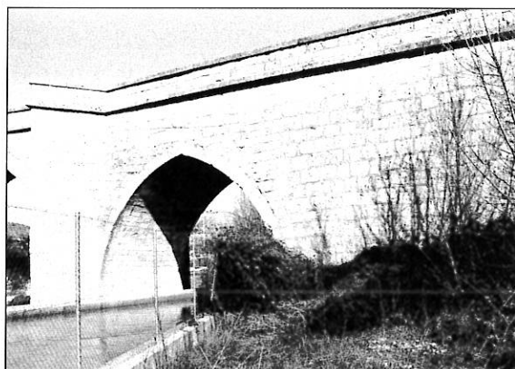
Figura 41. Arco sur del puente de San Martín de Rubiales, de construcción medieval. Es el único resto del primitivo puente insertado en la estructura actual.
