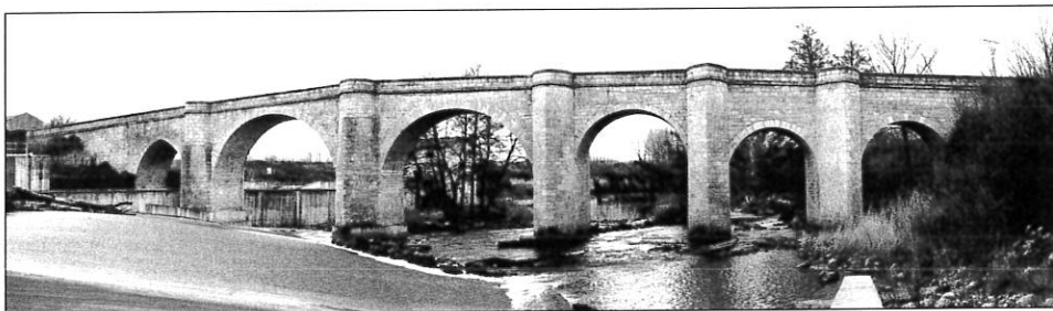
Figura 42. Vista general del puente de San Martín de Rubiales con el arco más antiguo, medieval, a la izquierda y los tres más modernos, de fines del XVIII, a la derecha. El penúltimo de ellos ha sido rehecho y a simple vista puede verse que se encuentra más bajo de lo que debiera.
