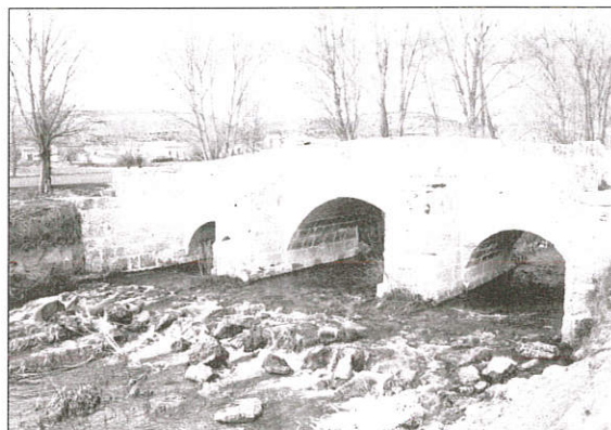
Figura 13. En Cabañes de Esgueva se alza un puente de gran unidad compositiva, conservándose además un tramo de calzada adyacente.
