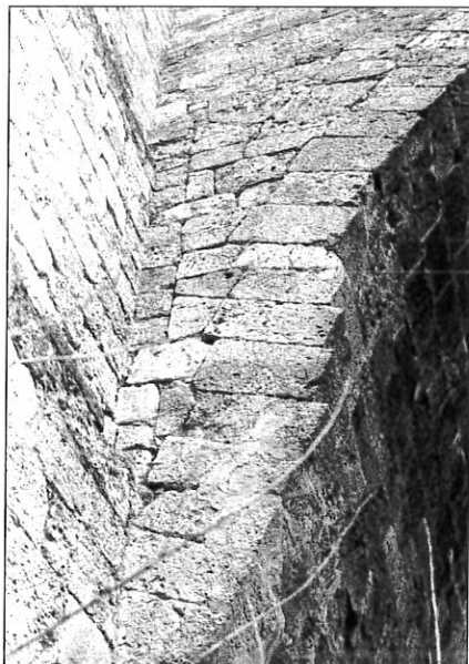
Figura 40. Arco norte del puente de Roa. Obsérvese el arranque con menor curvatura de los arcos anteriores, absorbidos actualmente en uno de mayor radio.
