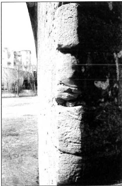
Figura 33. Tajamar de la primera pila del Puente Mayor de Aranda. El ángulo agudo es una característica estilística típica de los tajamares del siglo XVI, que podría ser la fecha de construcción de esta pila.
