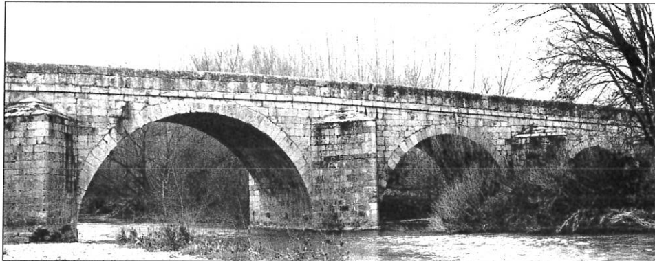
Figura 24. Vista aguas arriba del 5.º arco del puente de la Vid, con más de 12 metros de luz.
