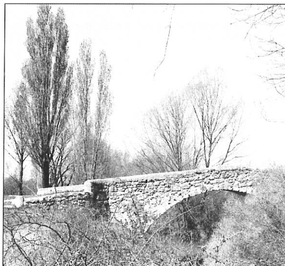
Figura 6. Acceso al Puente Viejo de San Juan del Monte, en el camino de Peñaranda, con su camino elevado entre muretes de piedra y el apartadero a la derecha de la embocadura.
