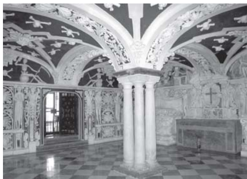
Cripta enterramiento de los condes de Buenavista
