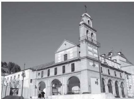
Vista general de la iglesia y convento de la Victoria
