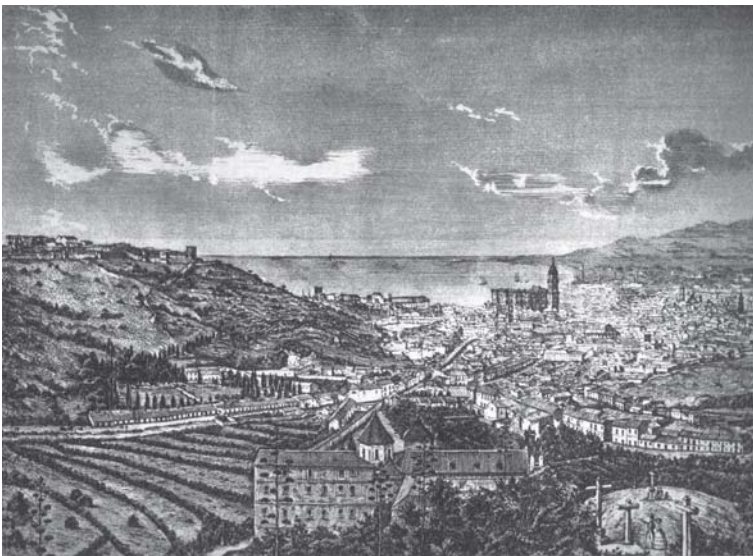
Málaga vista desde el Calvario y Convento de Ntra. Sra. de la Victoria
