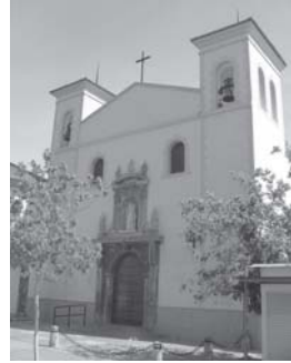
Iglesia de la Victoria en su estado actual
