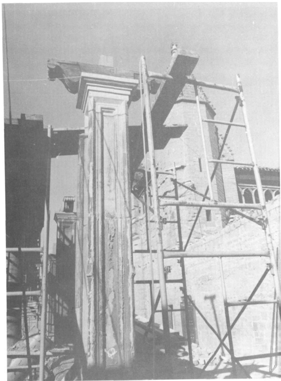
Foto 5.-Detalle de un soporte con su virotillo y la zapata de madera ya encajada, dispuesto para recibir la jácena de hierro.
