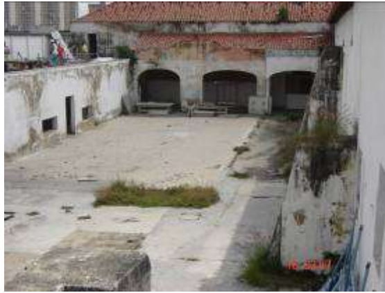
Fig. 2. Vista del Traspatio antes de la intervención arqueológica del proyecto EACUSAC
