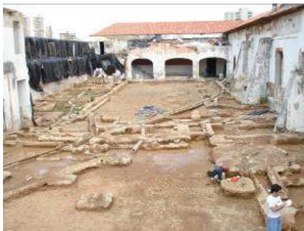
Fig. 13. Otros elementos constructivos despejados tras el trabajo de intervención arqueológica en el Traspatio II Etapa
