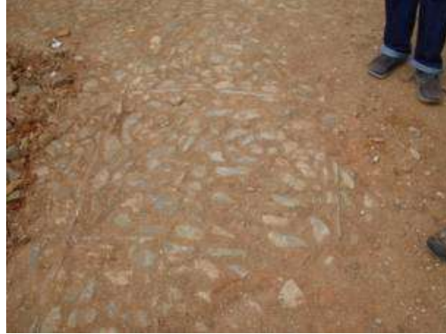
Fig. 14. Piso empedrado original del Patio Central. Obsérvese las líneas que forman cuadros
