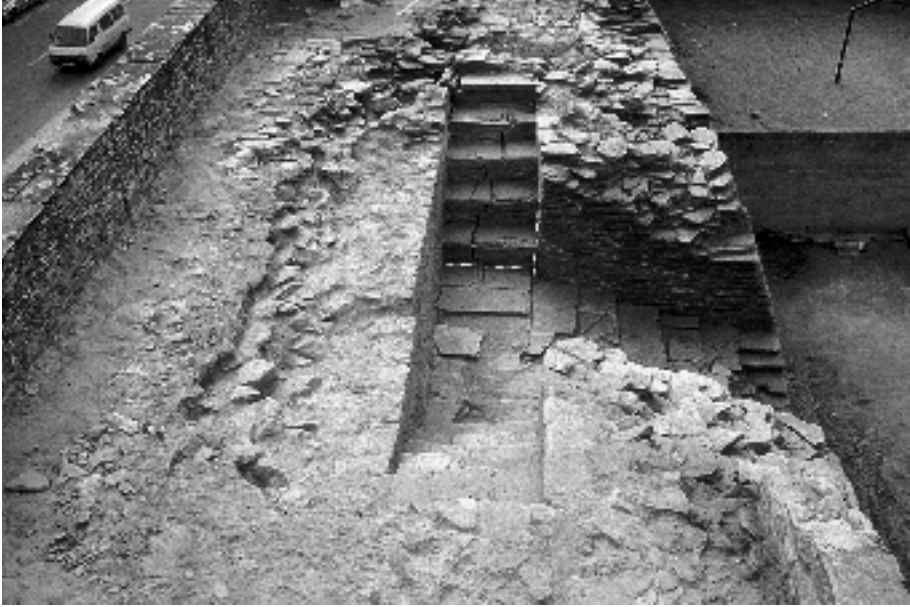
Fig. 5. Lucus Augusti. Escalera interior del cubo n° 58 (fotografía: E. Alcorta).
