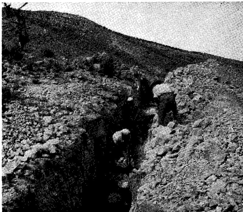
Figura 1.—Excavación de un canal subterráneo (La Horna).
