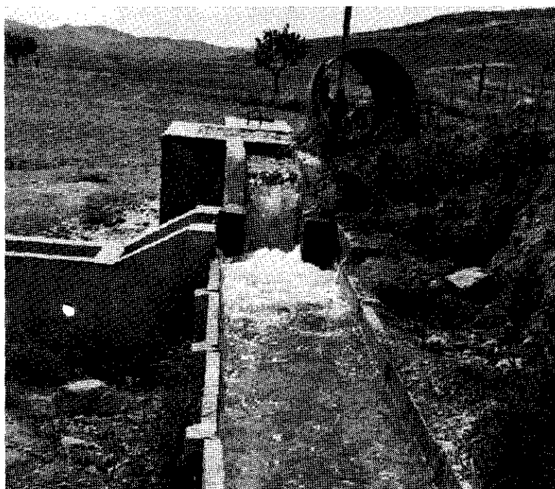
Figura 2.—Salida de la arqueta de distribución. Canal del Grupo Sindical. Sector SW.
