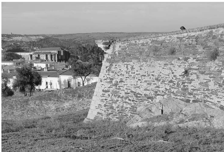
FIG. 6. Lienzo de muralla cercano al Baluarte del Rollo.
