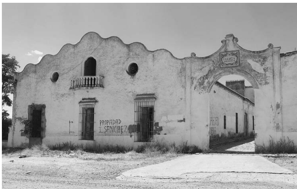
FIG. 2. Caserío La Garza. Fachada lateral de la vivienda junto a la portada de acceso al patio.
