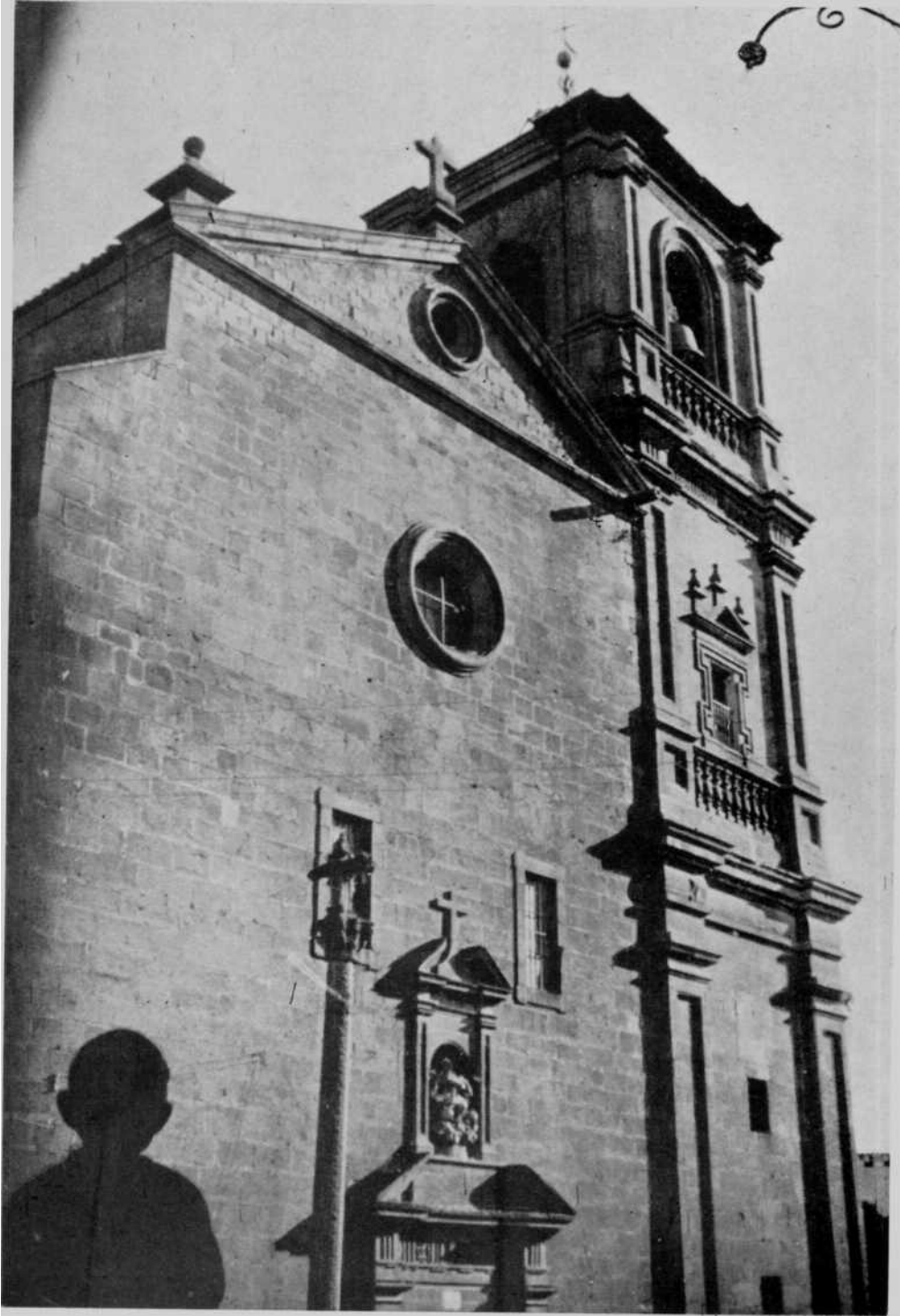
Santa María de Tafalla. Torre y fachada principal.
