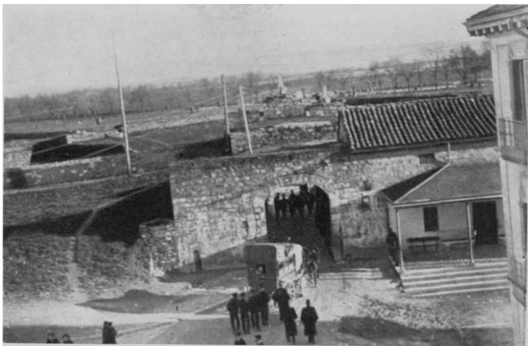
Fig. 10.—El mismo portal visto desde la calle de San Ignacio hacia 1890
