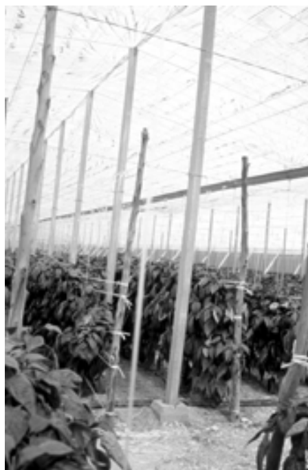
El invernadero «tipo Almería» admite múltiples materiales en su construcción. En esta fotografía se muestran pilares de hormigón
