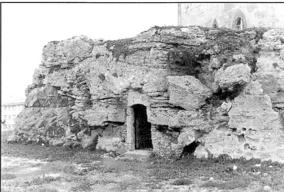
Vista de la entrada al cuerpo de guardia del antiguo reducto, excavado completamente en la roca del mismo cerro. 1812-13. (Foto del autor)
