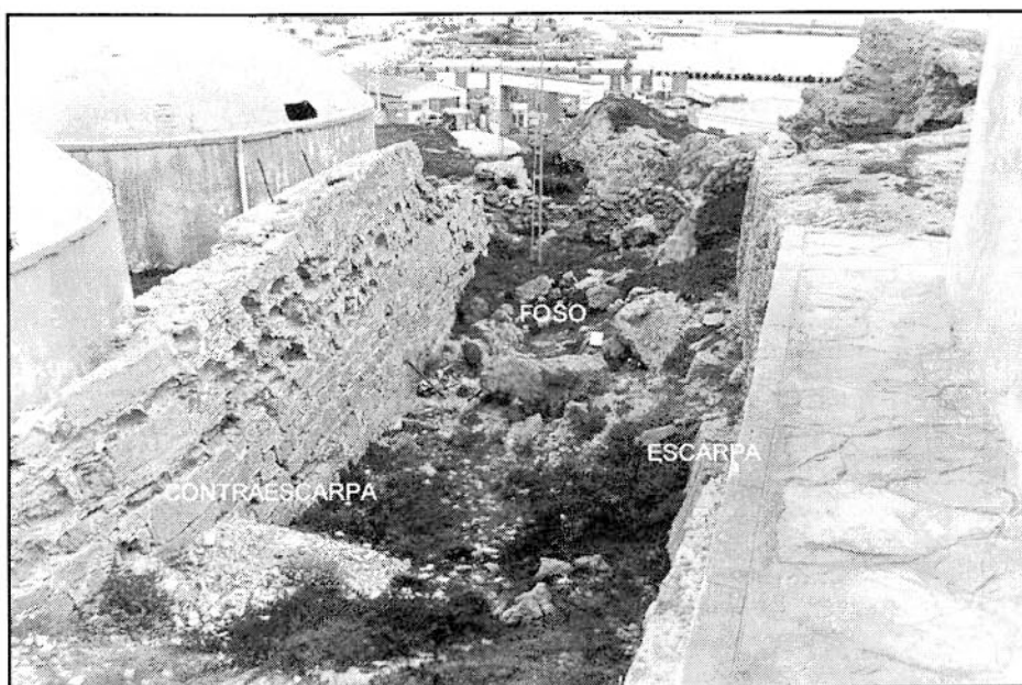
Estado actual del foso seco del antiguo reduto construido por los ingleses entre 1812 y 1813. (Foto del autor)
