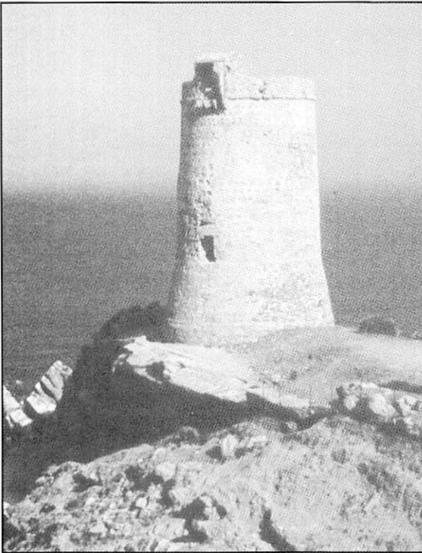
La Torre de Guadalmesí, que conserva la ladronera abalconada con que se protegía su entrada. (Foto Á. Sáez)
