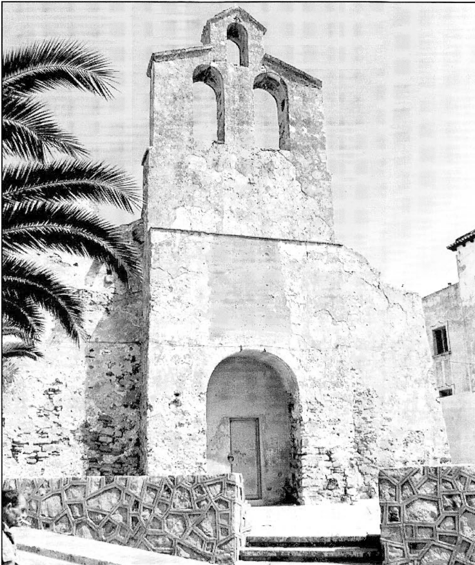
Fachada de la Iglesia de Santiago.
