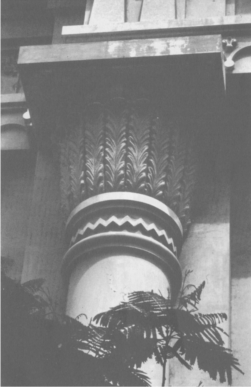
2) Capitel de una de las columnas de la entrada.
