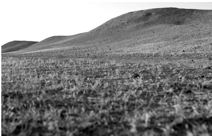
FIG. 6. Estado actual de la muralla de adobe de Tall as-Sin
