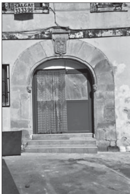
II. 3. Arco de ingreso
