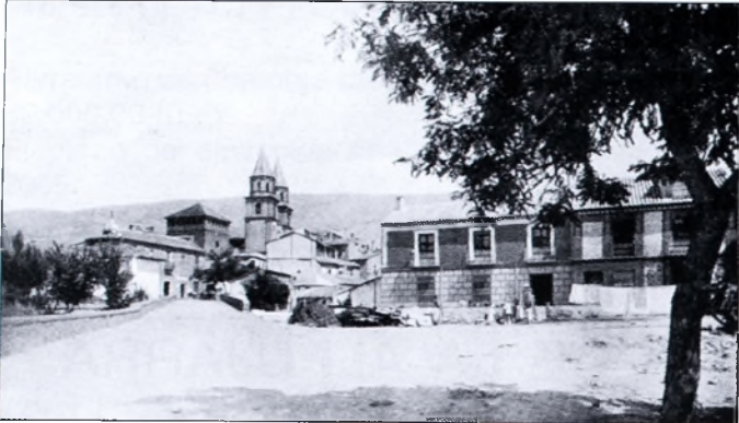
Órgiva. Vista parcial. Entrada a la ciudad por la carretera que procede de Albuñol
