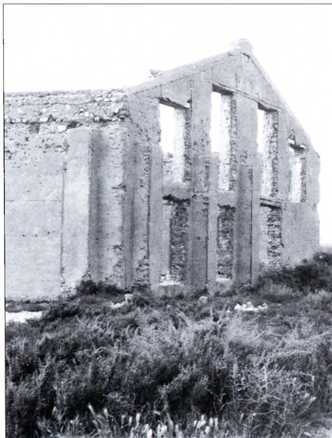
Aberturas en la fachada este del edificio «Fábrica». Foto J. A. Peña.
