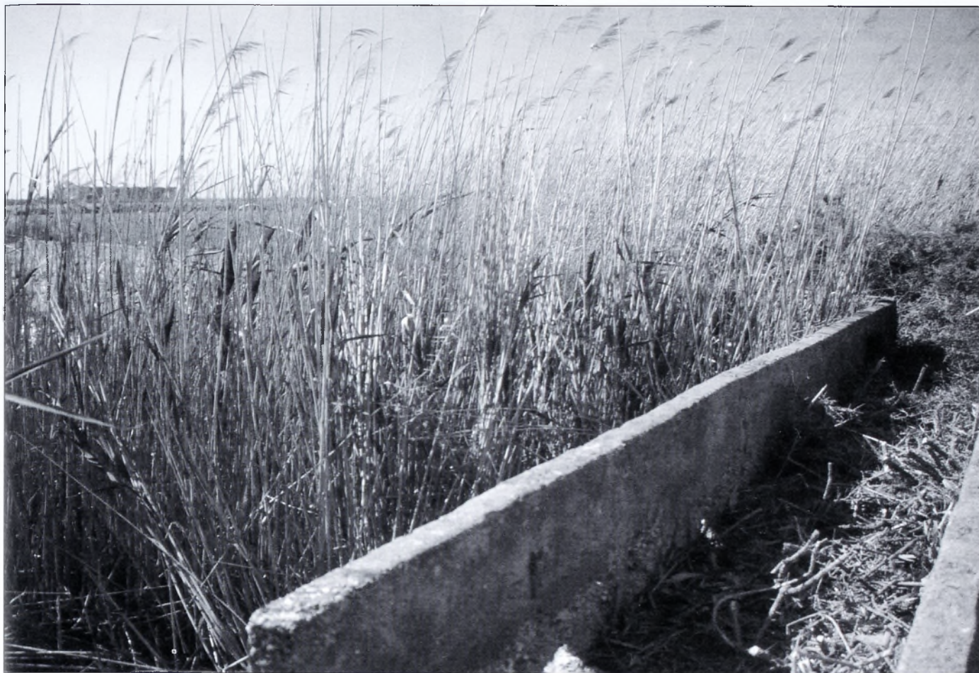
Canal de distribución de agua. Foto J. A. Peña.
