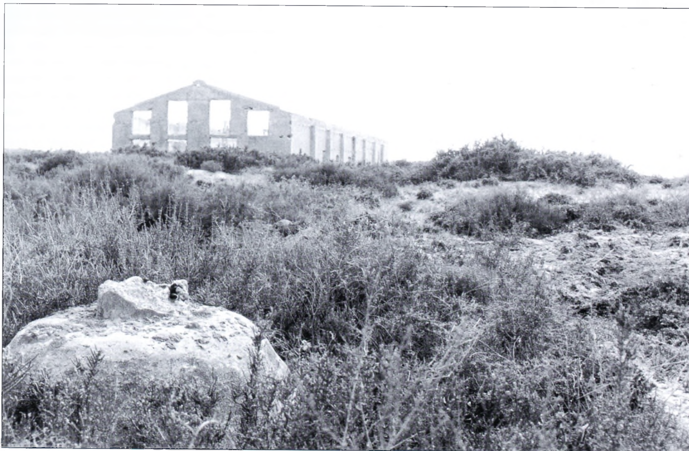
«Edificio Fábrica», destinado a almacén y a la molienda. Foto J. A. Peña.
