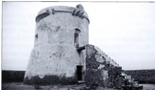
Lám. 2. Torre de San Miguel de Cabo de Gata (Almería).
