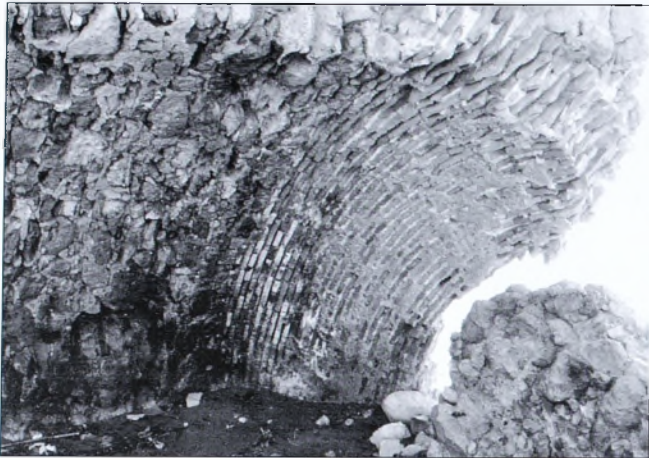
Lám. 4. Ruinas de la torre de Las Entinas.
