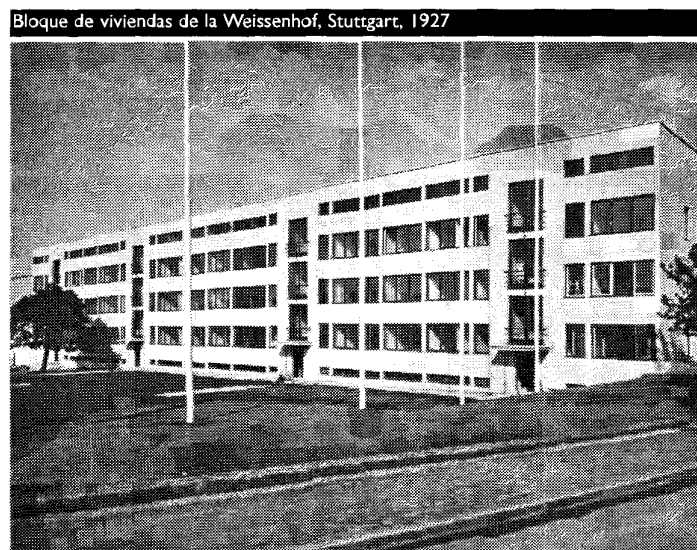
Bloque de viviendas de la Weissenhof, Stuttgart, 1927
