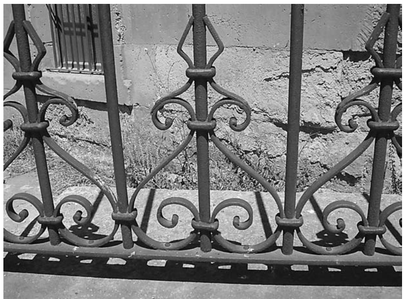
Detalle do remachado e das abrazadeiras dun enreixado.
