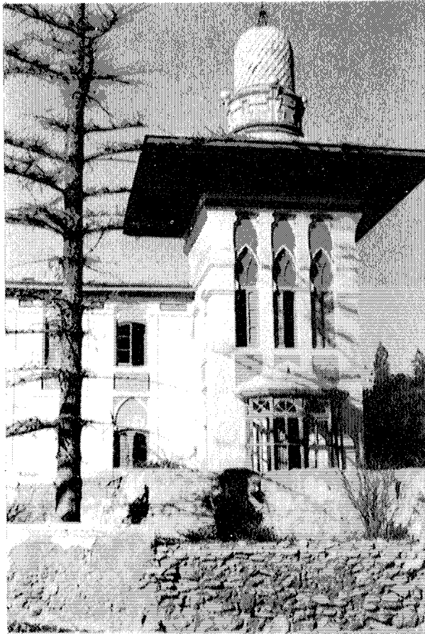
Casa de «La Marina», torre lateral.
