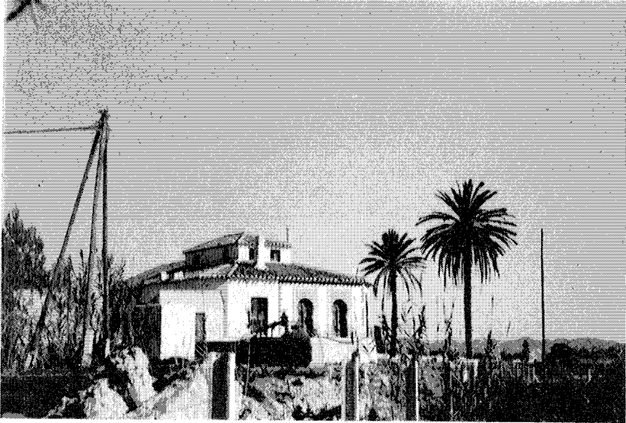
Cortijo de Montoro, vista desde la carretera.
