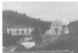
Ampliación de su esquina superior izquierda, donde puede verse la fachada de La Popa y parte de la hermosa calzada de acceso. Febrero de 1940.
