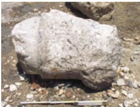
Fig. 4 Base fracturada do Pilar 3 integrada no derrube do S.S.A.1.
