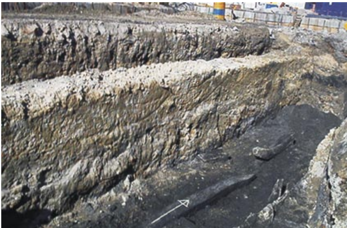
Fig. 2 Poderosa estrutura em alvenaria, sendo visíveis em plano, elementos de embarcações e parte de uma estrutura de cofragem em madeira, colocados a descoberto durante o prosseguimento do acompanhamento arqueológico dos trabalhos no troço sul da Avenida D. Carlos I (foto S. Antunes).
