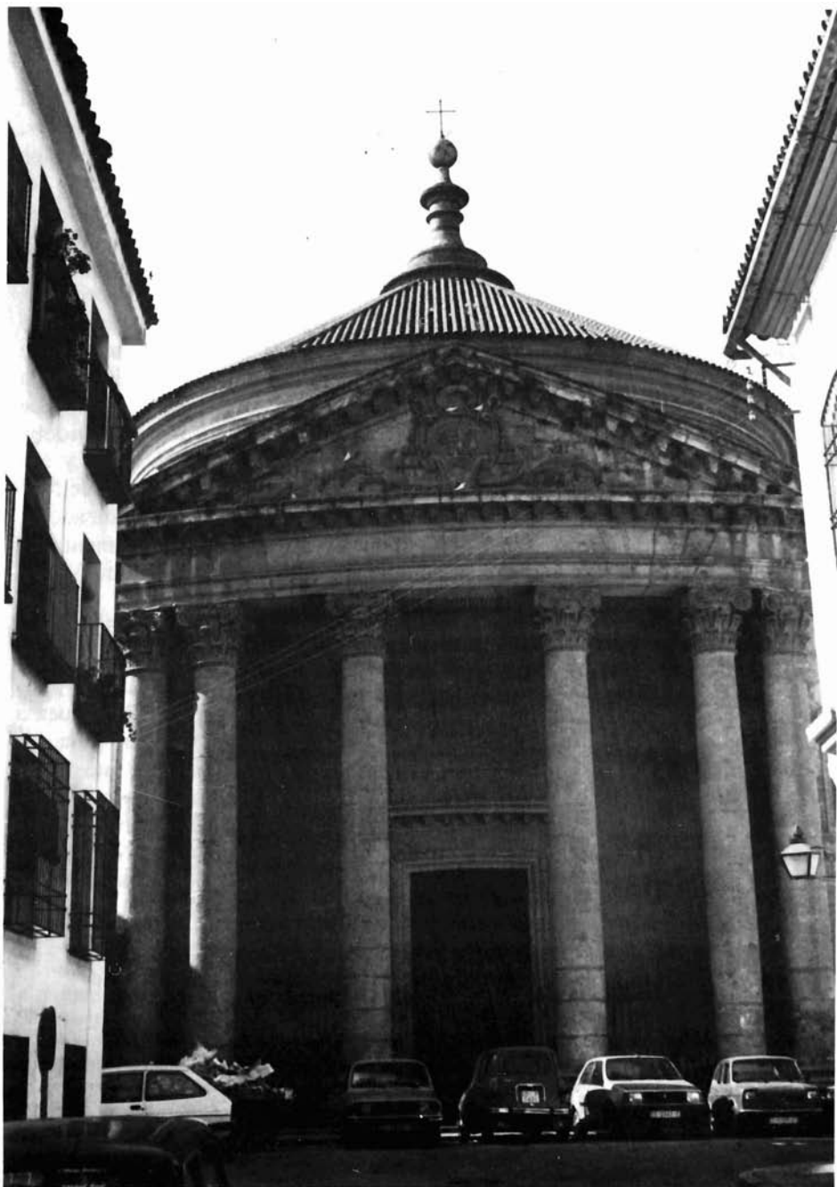
Córdoba. Colegio de Santa Victoria. Pórtico de la iglesia.
